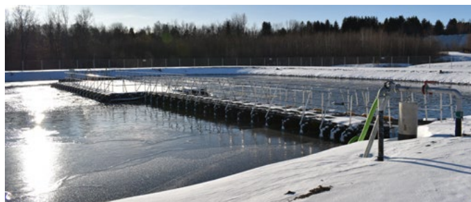
Étang aéré : technologie KAMAK de Bionest
