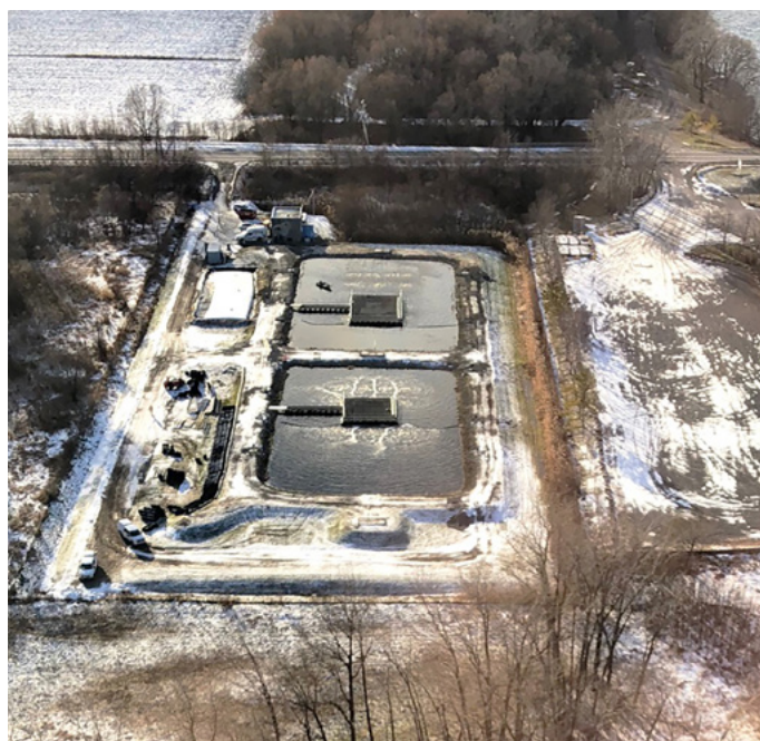
Vue aérienne de la technologie KAMAK
